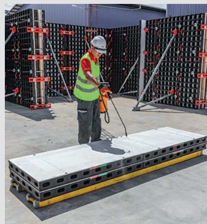
配合压力喷雾器轻松使用派利Plasto Clean脱模剂
