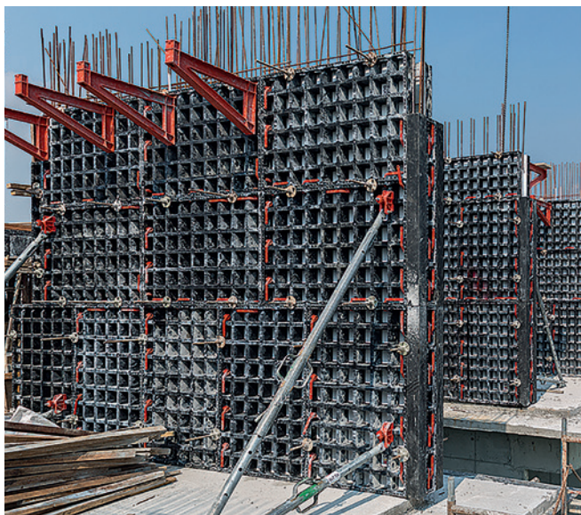
轻质系统模板首次成功用于建造剪力墙。
