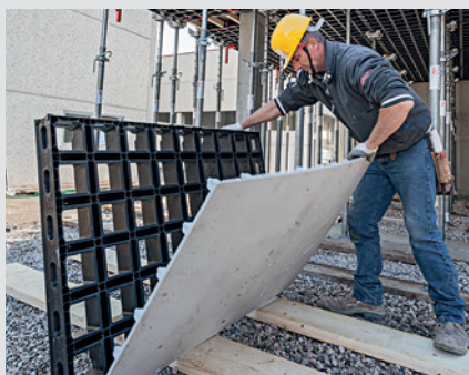
2. 移除损坏的面板
