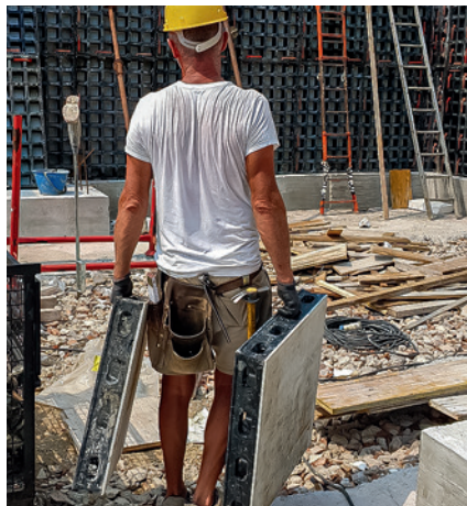
DUO在框架元件中具有符合人体工程学的开口, 专为安装模板连接器而设计。在建筑工地上运输元件时, 这些开口也可用作凹槽。
